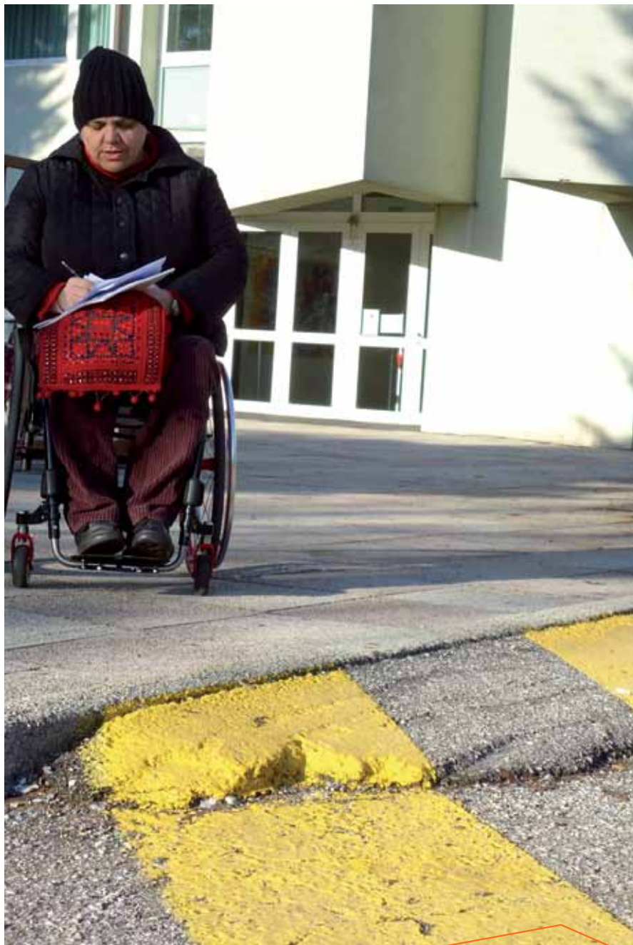
Scuola media: particolare dello scivolo tra marciapiede e strada
