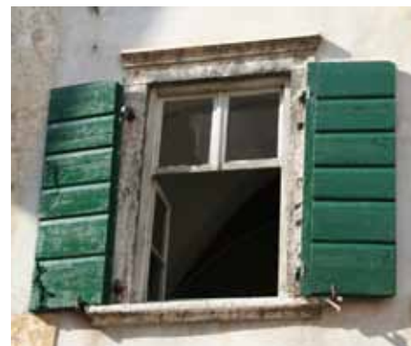
interno con assi orizzontali
