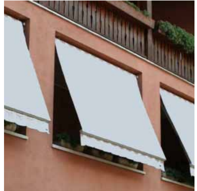
TENDE PARASOLE IN FACCIATA INTERNA DI EDIFICIO RESIDENZIALE
