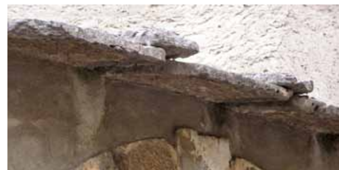
copertura in lastre di pietra naturale locale
