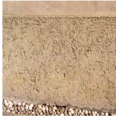
zoccolo in intonaco a sbriccio
