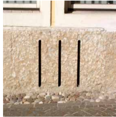
zoccolo in pietra con fori d'aerazione cantina
