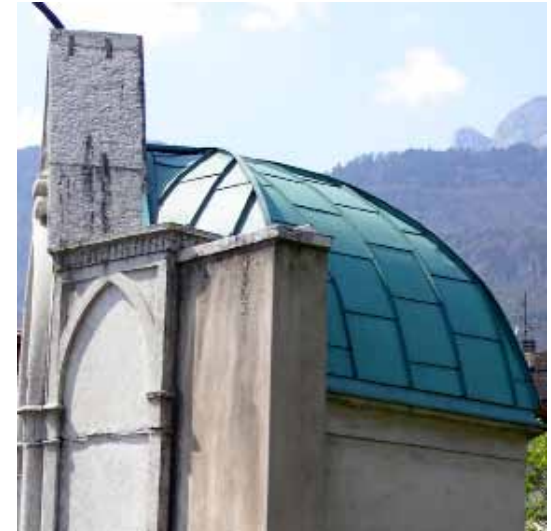
manto di copertura in rame
