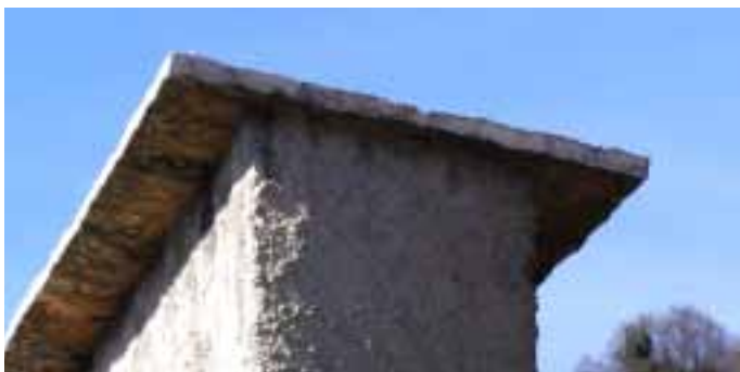
copertura in lastre di pietra naturale locale
