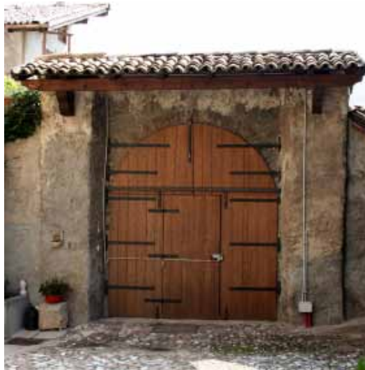
manto di copertura in coppi a due falde
