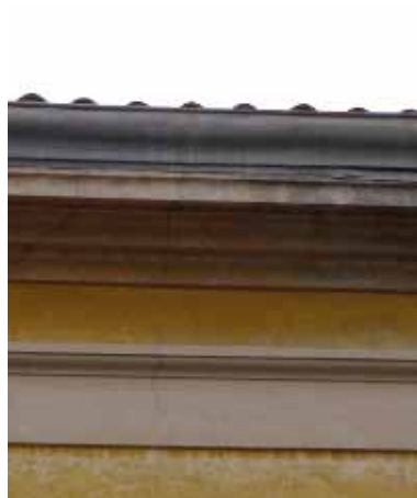
CORNICIONE IN LEGNO CON MO- DANATURE INTONACATE SAGOMA- TE SU ASSITO IN LEGNO
