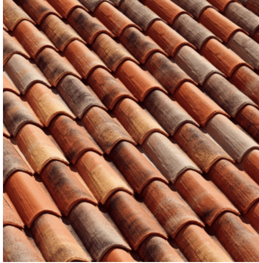
manto di copertura in tegola coppo
