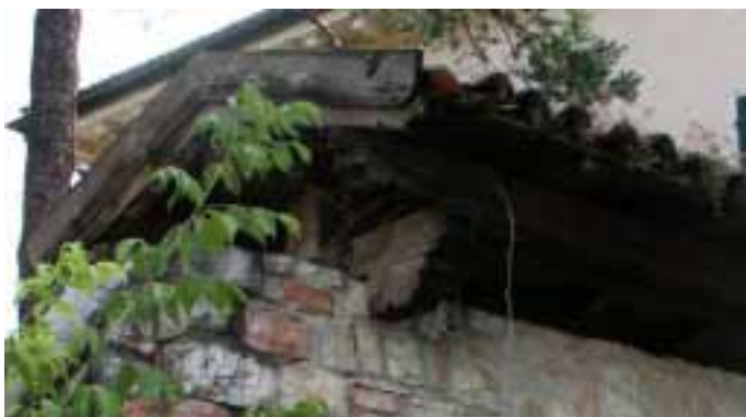
copertura in coppi con struttura in legno
