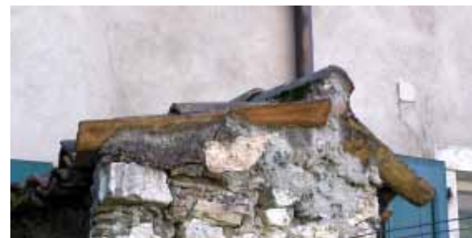
copertura in coppi a due falde asimmetriche
