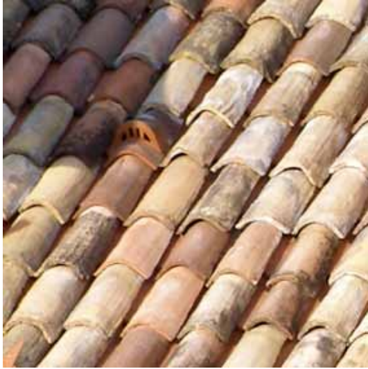
manto di copertura in coppi
